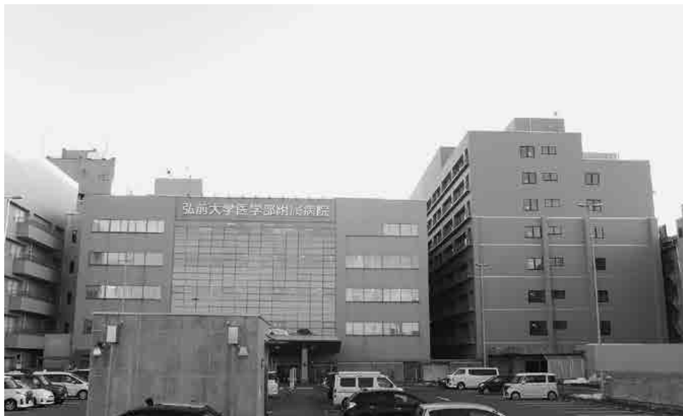
新病棟「入院棟東」を稼働（令和5年7月）
