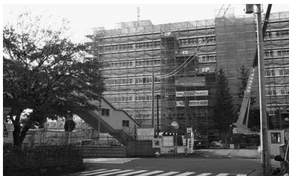
写真1 改修中の東側総合研究棟。大型クレーンが活躍中。
