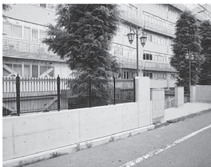
臨床研究棟西側フェンス整備及び外灯整備
