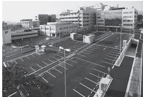
図 1. 附属病院正面駐車場全景
