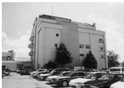
1. 施設西側外観
