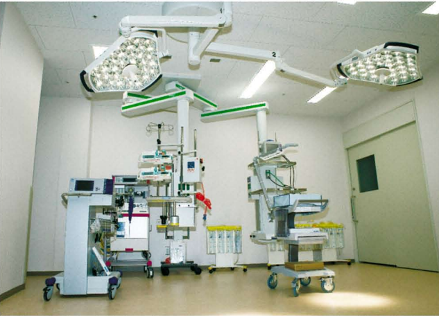
▲高度救命救急センター救急処置室
