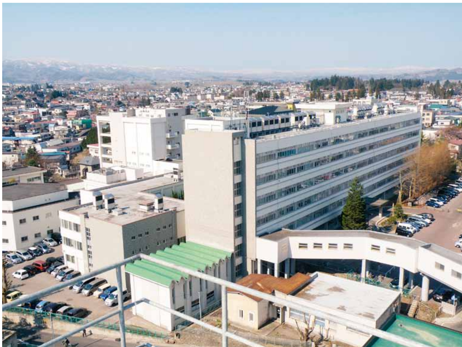
大学院医学研究科・医学部，社会医学センター，附属動物実験施設， 附属図書館医学部分館，アイソトープ総合実験棟，講義棟
